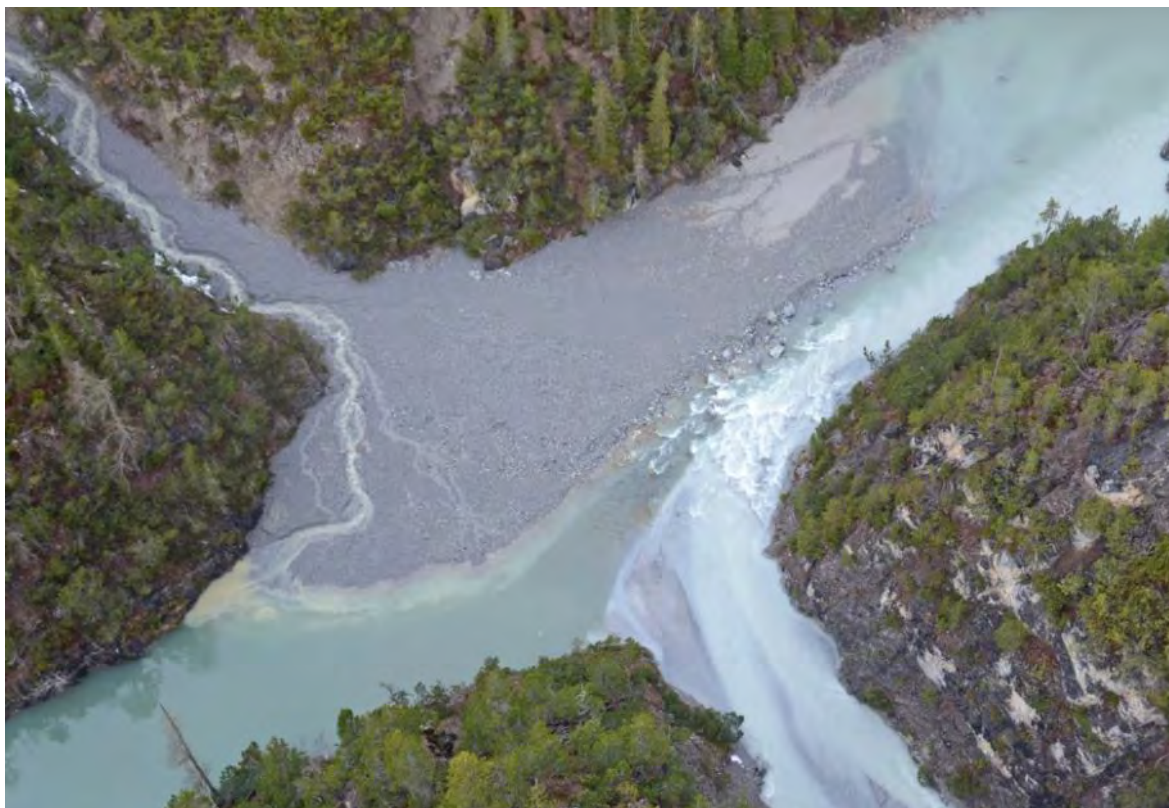
Abb. 10: Bereich um die Fuornbachmündung (rechts) (bei Stauziel innerhalb der Stauwurzel des Beckens Ova Spin). Ablagerungen, die dem Schadensereignis zugeordnet werden können, sind nicht feststellbar.
