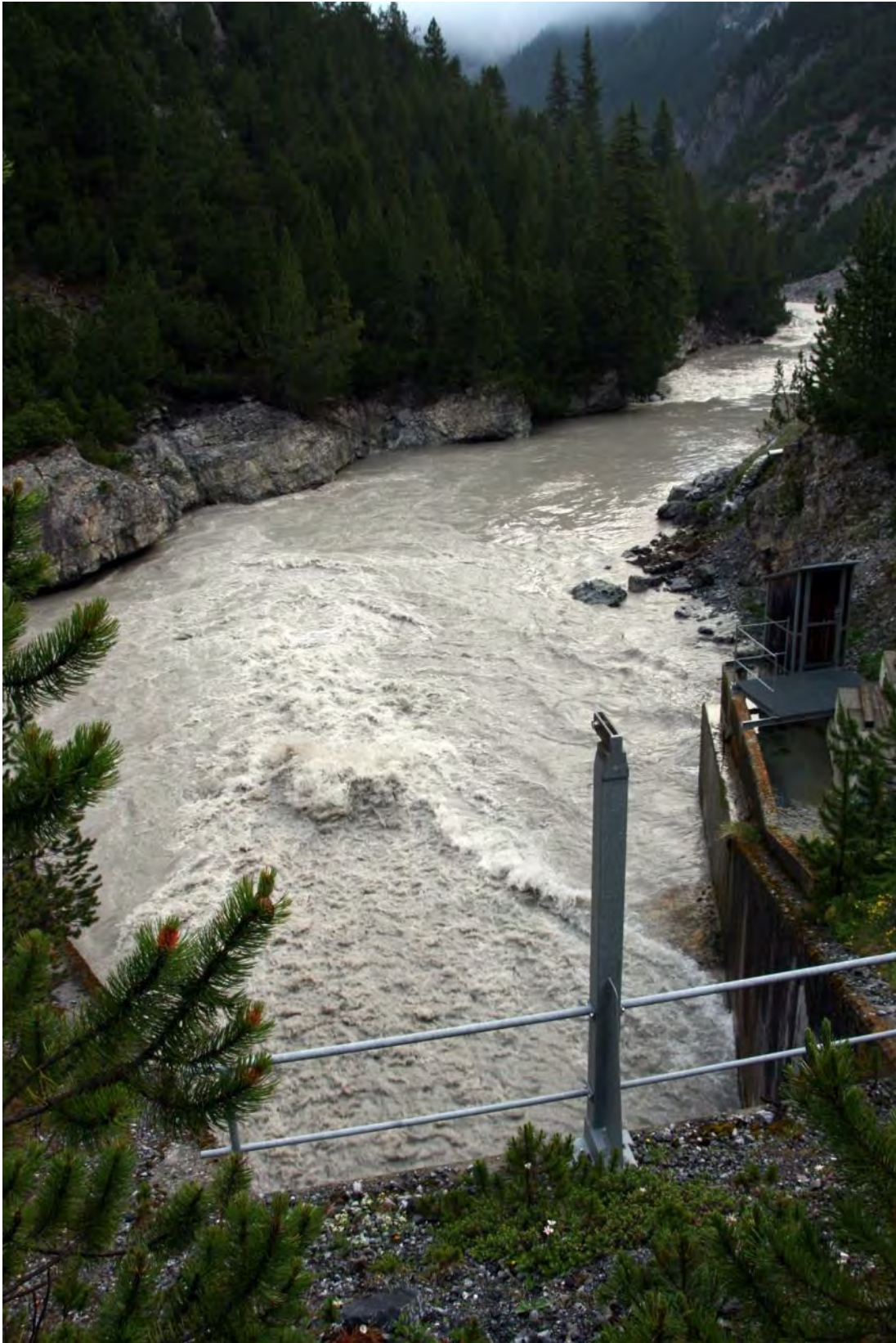
Abb. 5: Tosbecken Grundablass Punt dal Gall, Öffnung Grundablass (Bildaufnahme 07:43 Uhr, Abfluss ca. 5.4 m 3 /s).
