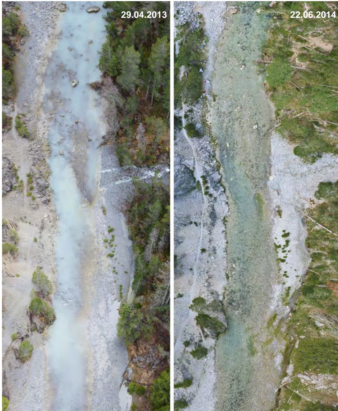
Abb. 13: Vergleichende Luftaufnahmen 2013–2014 am oberen Spöl. Abschnitt: Punt dall Gall – Hydrologische Messstation (ca. 300 m uh. Punt dal Gall).
