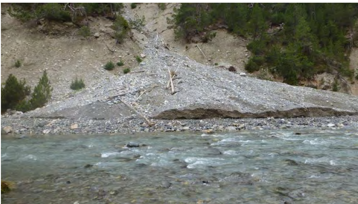
Abb. 4: Erosion seitlicher Schuttkegel (ca. 900 m unterhalb Staumauer Pt dal Gall).
